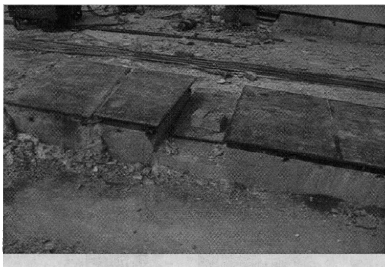
图 2-2 台座断口图片
