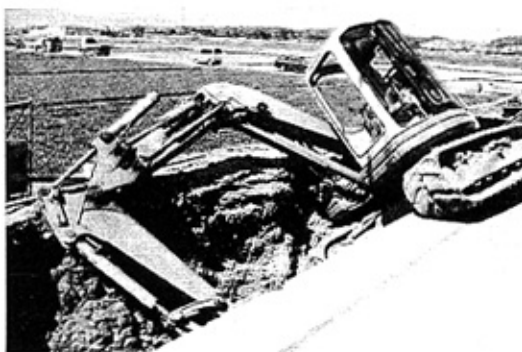
(a) 挖掘机在沟槽一侧施工
