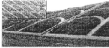
图 3-19 某高速公路弧形骨架植草护坡景观绿化工程
