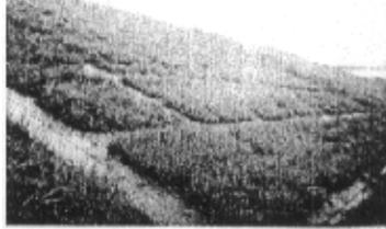
图 3-21 湖北省高速公路方形骨架植草护坡景观绿化工程
