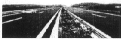
图 3-16 某高速公路中央分隔带防眩绿化
