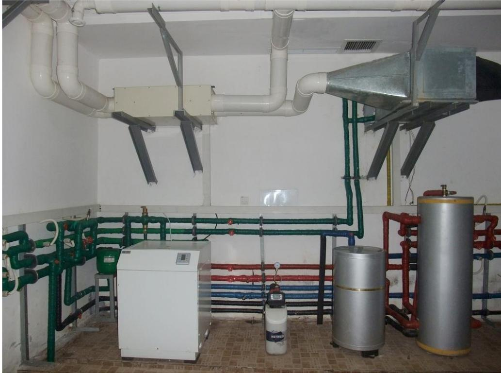
图 5.4 本研究实验室辐射空调冷却除湿实物图
