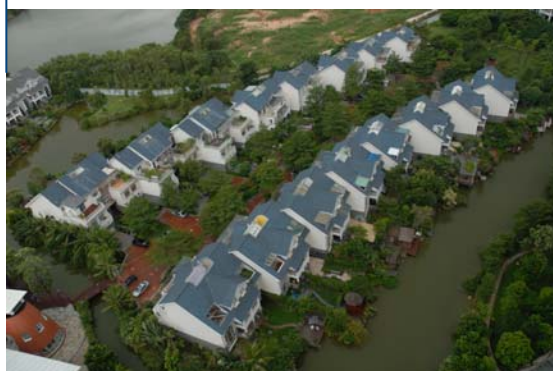
深圳百仕达3期项目样板区全景
